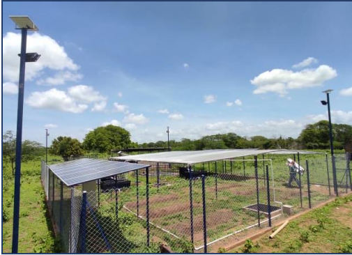
Sistema de bombeo aislado
